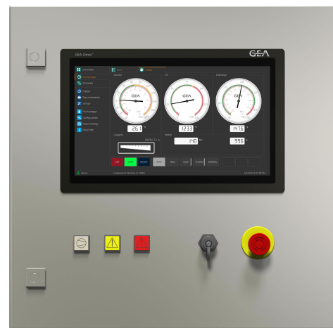
Abb.7: GEA Omni Außenansicht mit Meldeleuchten
